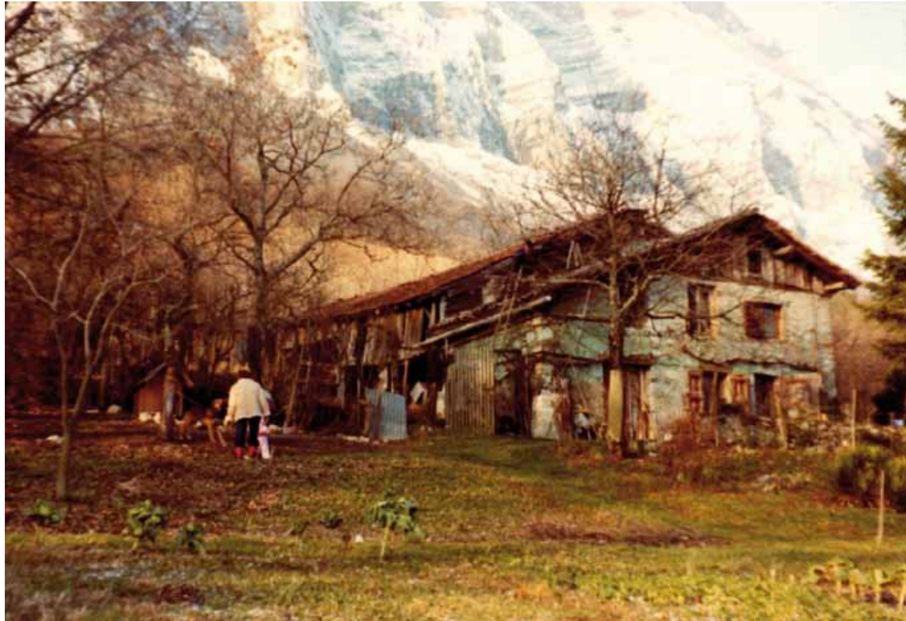
Chalet de Meylan. Angèle et Robert restaurent la toiture. À l'arrière, le Saint-Eynard enneigé (vers 1950).
