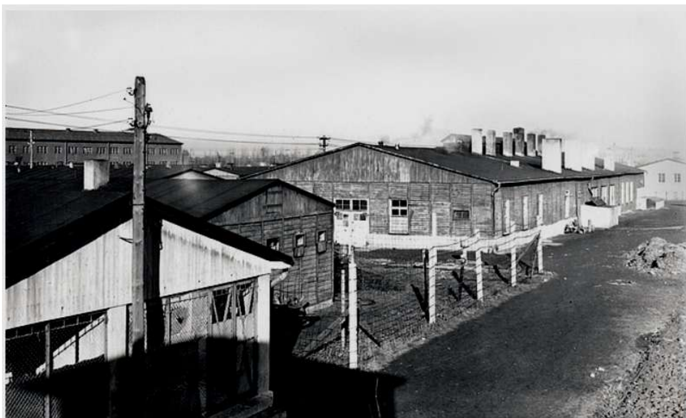
À l'intérieur du camp : ancienne baraque de désinfection (« bains-douches des détenus »), cachot, baraque des cuisines ; au fond à gauche le bâtiment en pierre pour l'hébergement des déportés, encore en place aujourd'hui.
