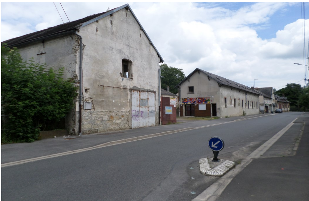
Saint-Pathus : la ferme Pluinage de 1928 à 1998, bâtiments abandonnés depuis (cliché juin 2016)
